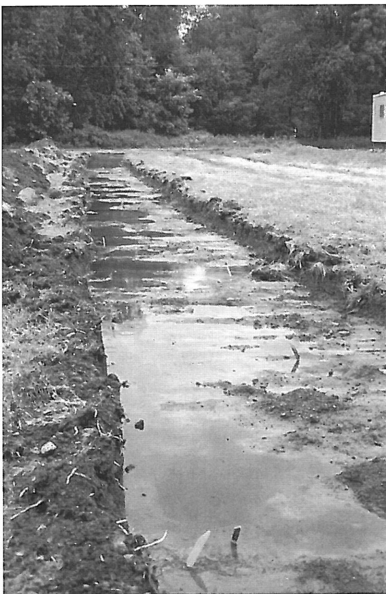
Figur 2. Det myckna regnandet ledde till att schakten översvämmades, något som försvårade arbetet. Foto: Lotta Högrell.
